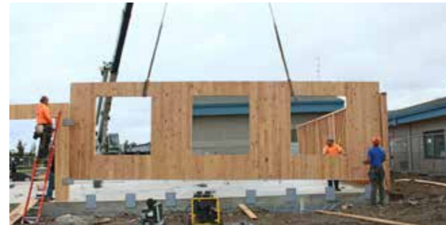
fig. 46. Bouwen met CLT-panels levert meerdere voordelen op bron: theurbanist.org
