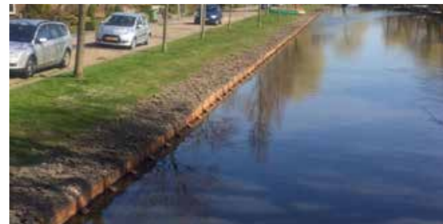
fig. 71. Beschoeiing langs een sloot gemaakt van een geschikte houtsoort bron: Benecke
