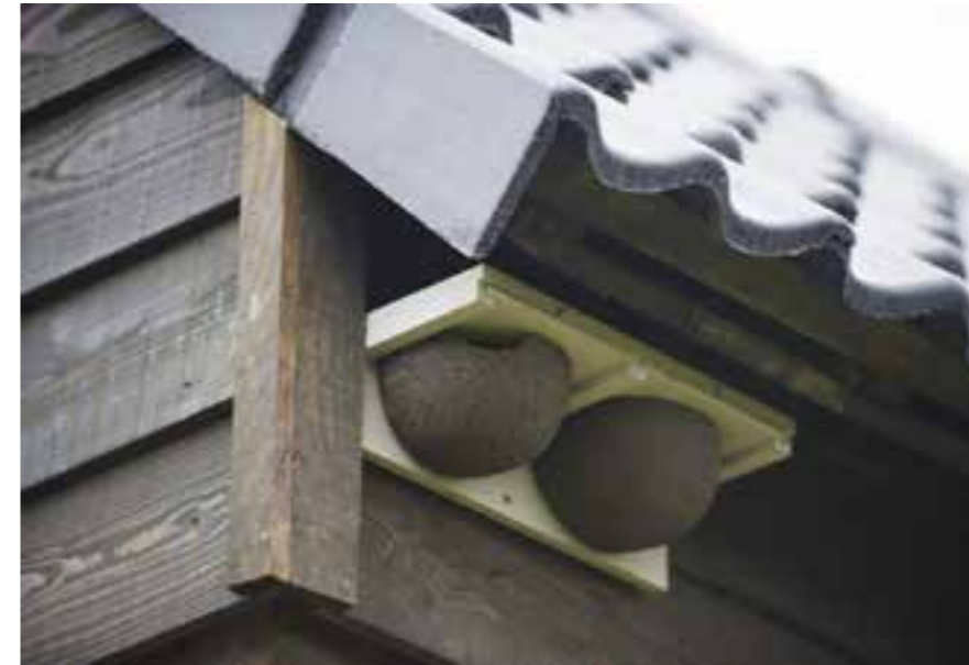
fig. 45. Natuurinclusief bouwen: plek voor vleermuizen of vogels onder het dak bron: jonkershovenier.nl
